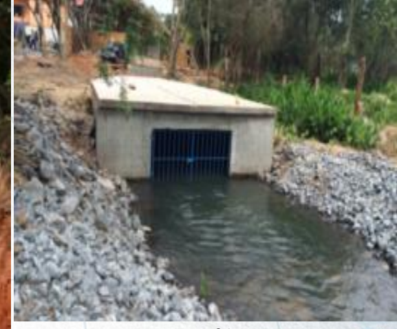
Bombeamento de 1 m 3 /s do Rio Guaió para o Represa Taiaçupeba.
