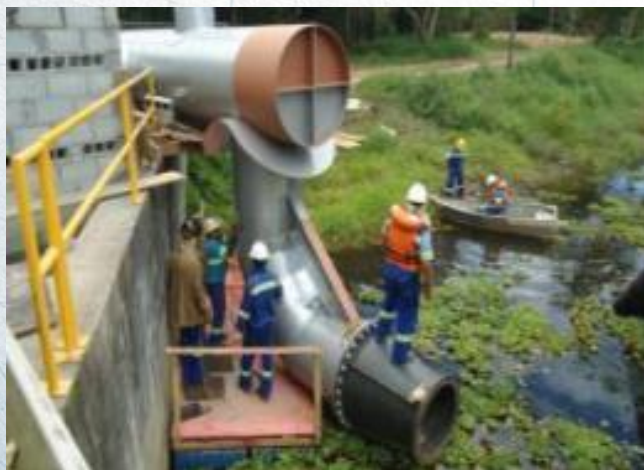
Ampliação da EEAB Biritiba Mirim em 3 m 3 /s
