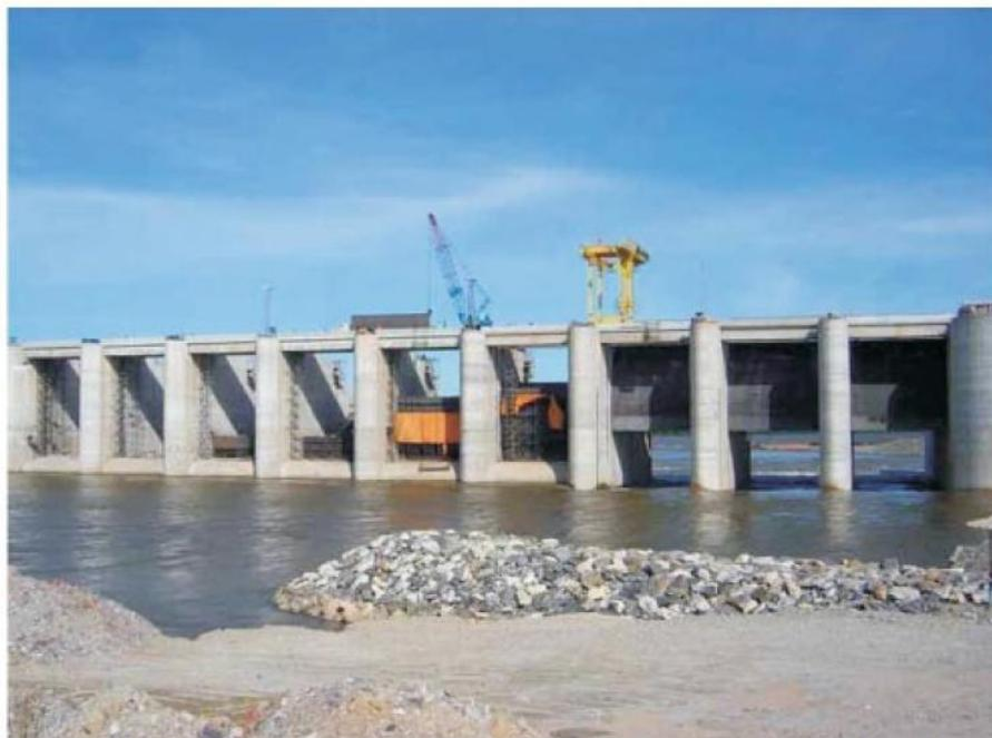
Foto 19 - Desvio Através de Soleiras Rebaixadas em Três Vãos do Vertedouro de Peixe Angical
