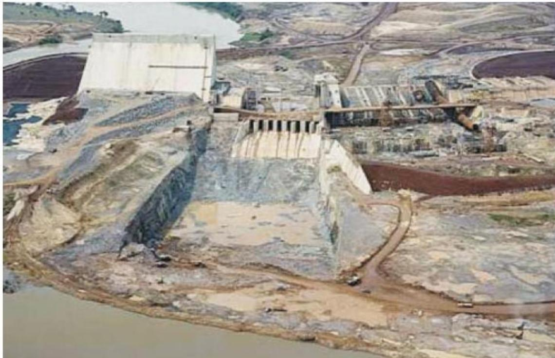
Foto 10 - Desvio Primeira Fase da UHE Itumbiara - Estruturas em Construção
