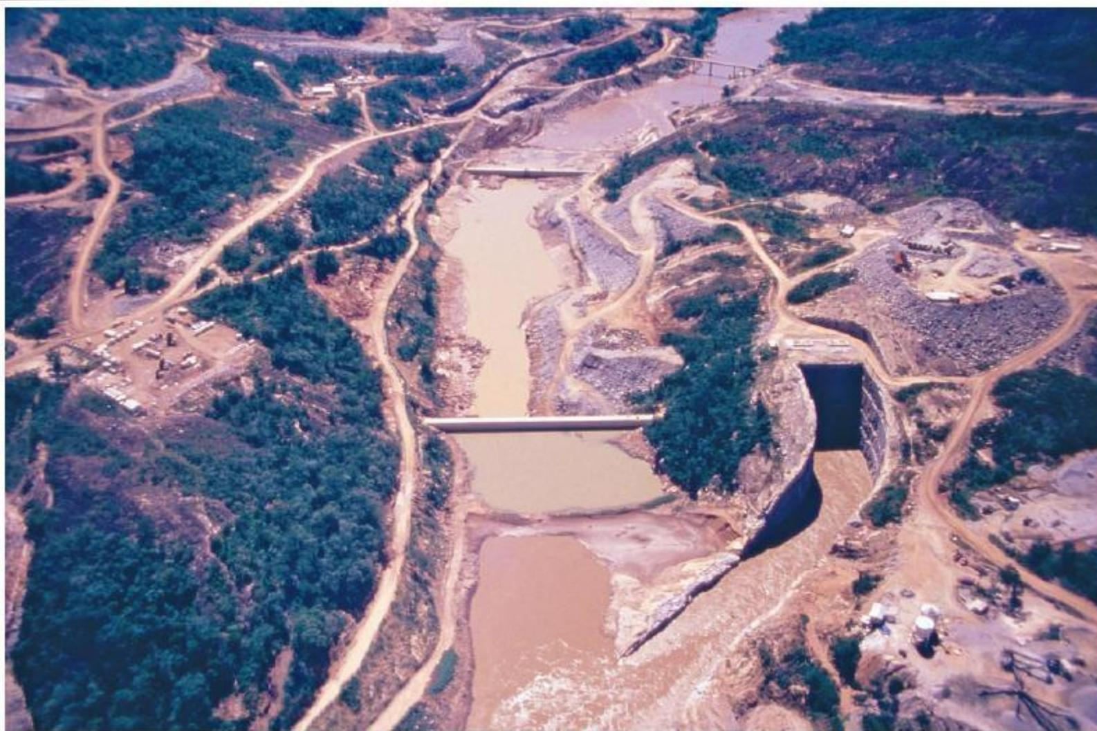
Foto 2 - Vista geral do esquema de desvio (ensecadeiras galgáveis e túnel)
