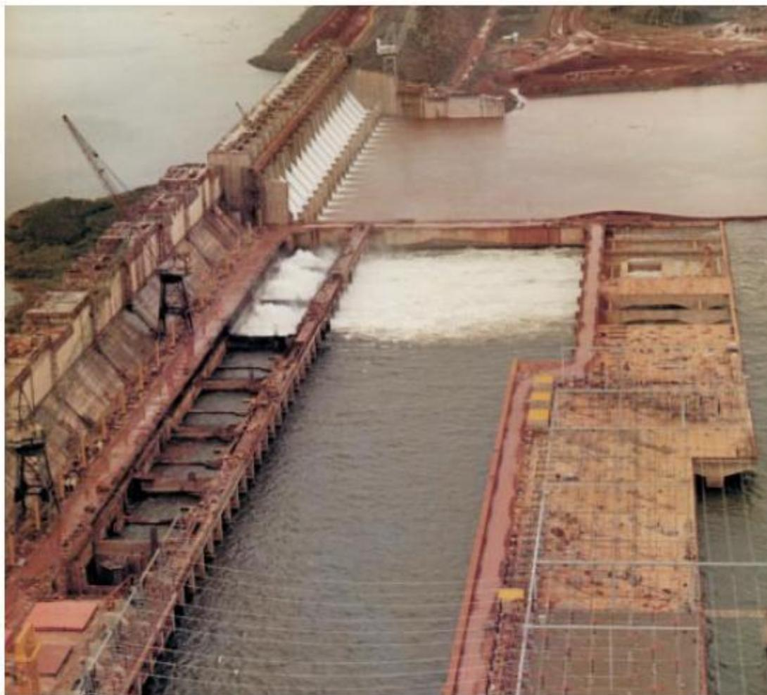
Foto 20 - Final do Desvio da 2ª Fase. Tomada de Água/Casa de Força e Início de Operação do Vertedouro da UHE Ilha Solteira
