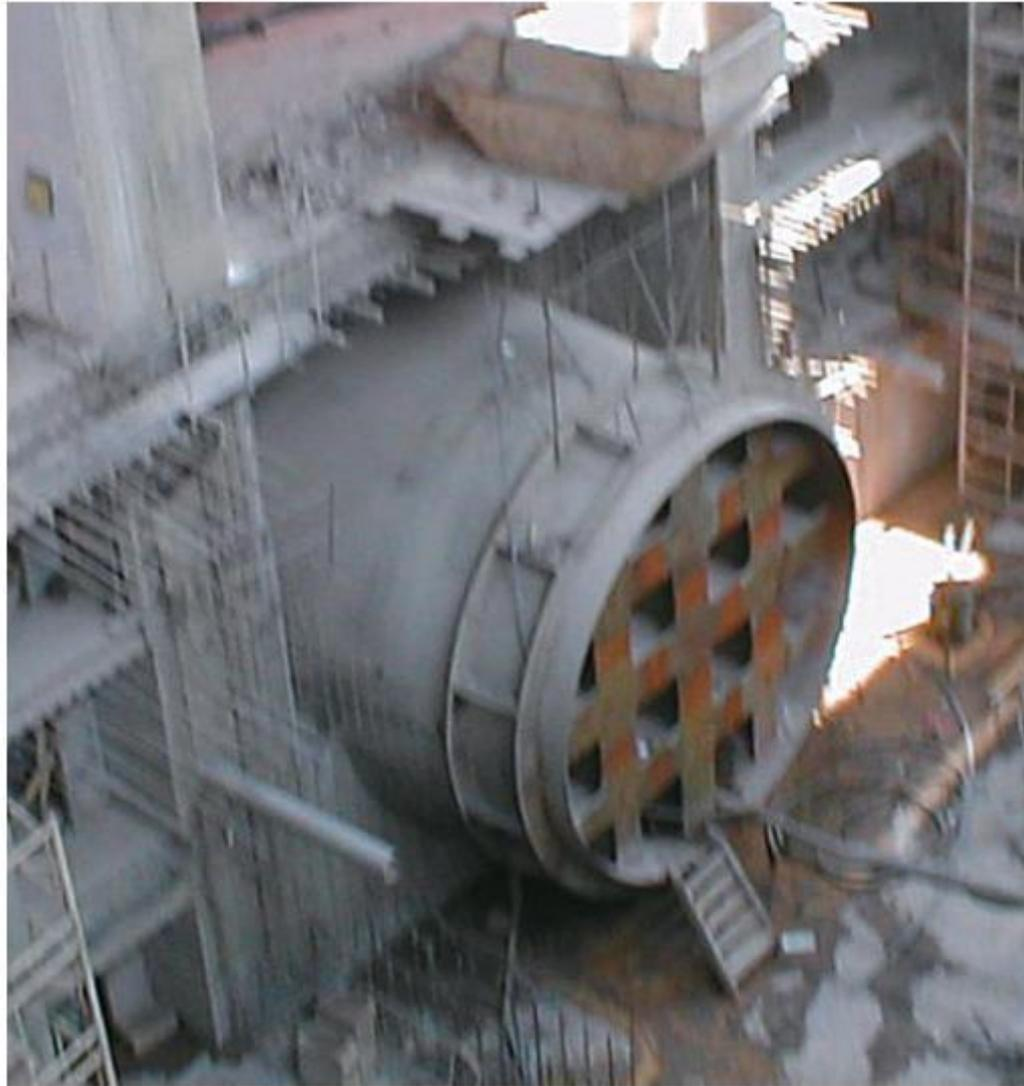
Foto 22 - Placa Dissipadora de Energia Colocada no Conduto Forçado
