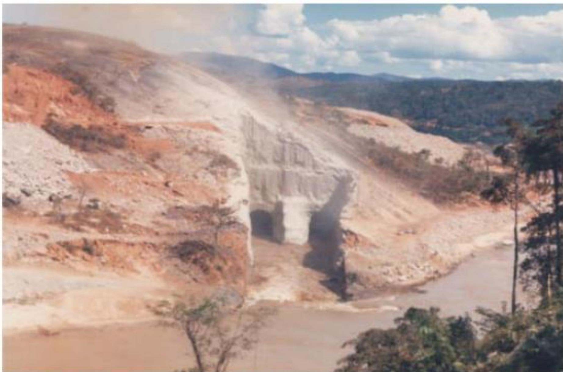
Foto 2 - Emboque do Túnel de Serra da Mesa com Galgamento do Septo de Proteção
