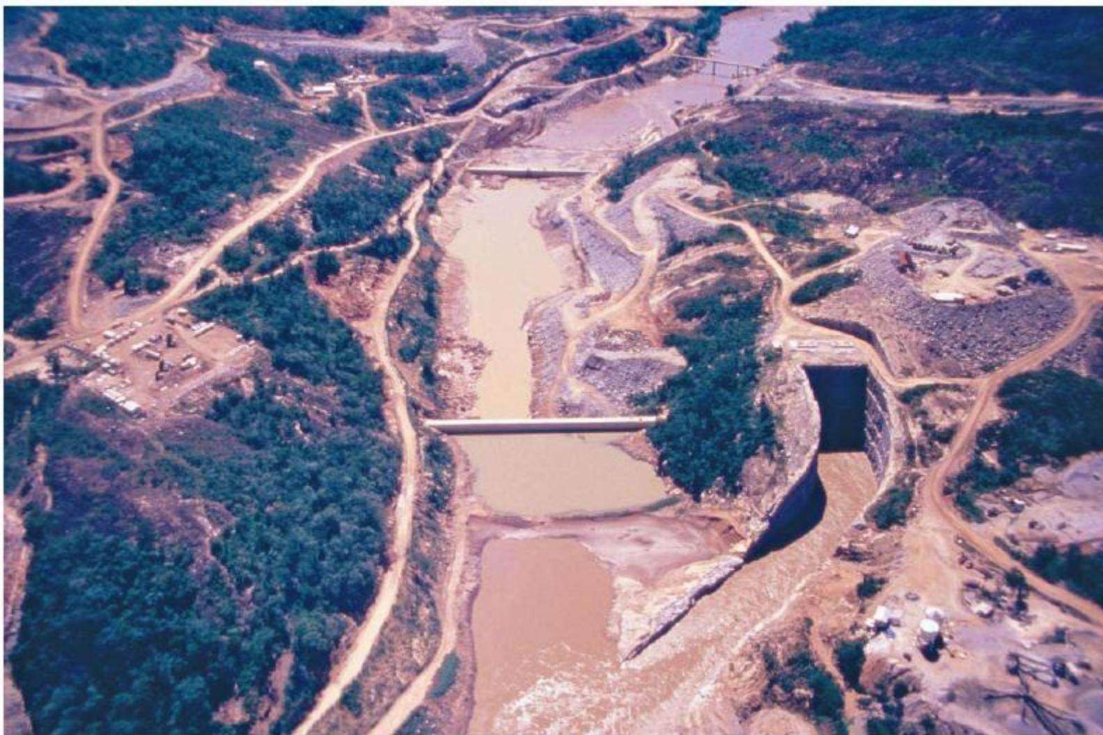
Foto 2 - Vista geral do esquema de desvio (ensacadeiras galgáveis e túnel)
