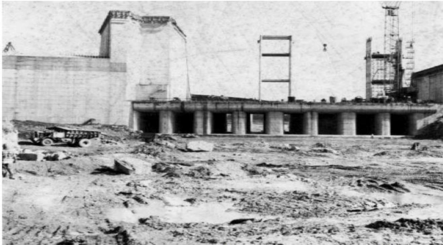
Foto 11 - Galerias de Desvio e Blocos Rebaixados do Vertedor de Itumbiara
