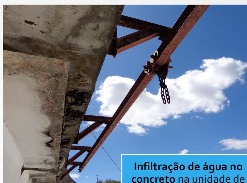
**Infiltração de água no concreto** na unidade de saída
