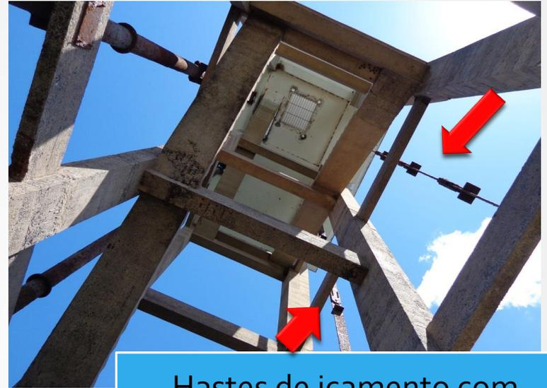
Hastes de içamento com corrosão
