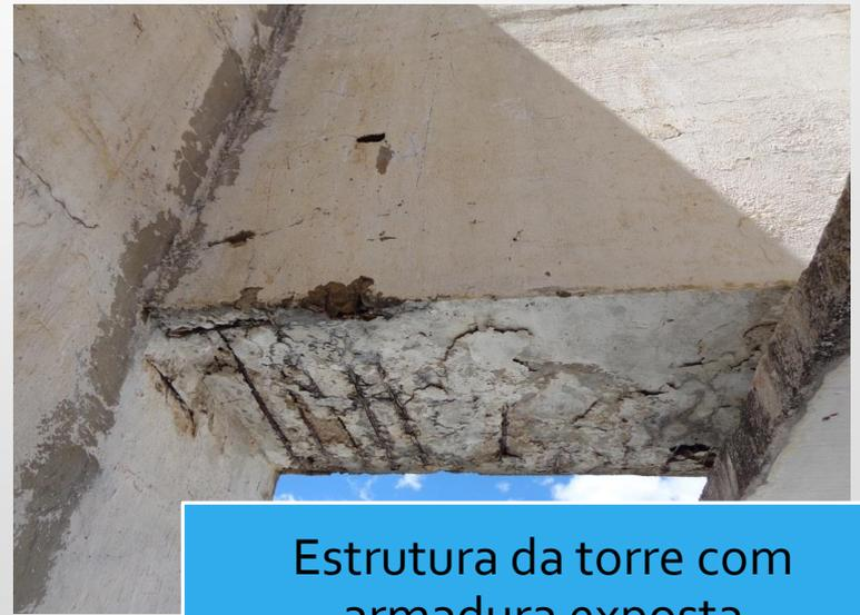
Estrutura da torre com armadura exposta
