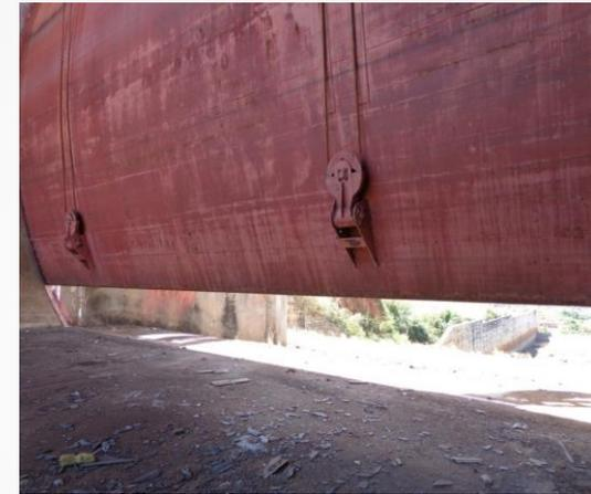
As peças fixas da comporta apresentam muitos pontos de **corrosão**, necessitando de jateamento abrasivo e pintura
