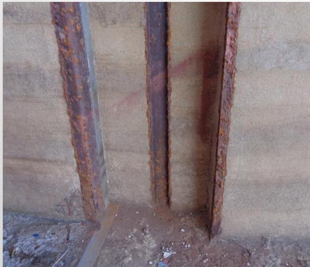
Guias dos pontos de içamento **com avançado grau de corrosão**
