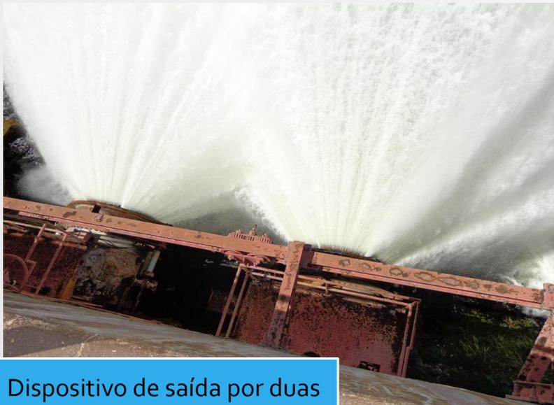
Dispositivo de saída por duas válvula dispersora, que se encontra **com bastante corrosão**
