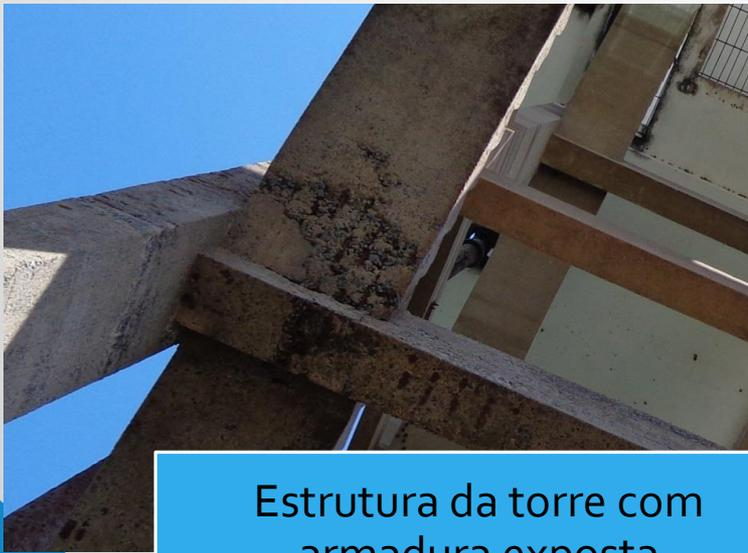
Estrutura da torre com armadura exposta
