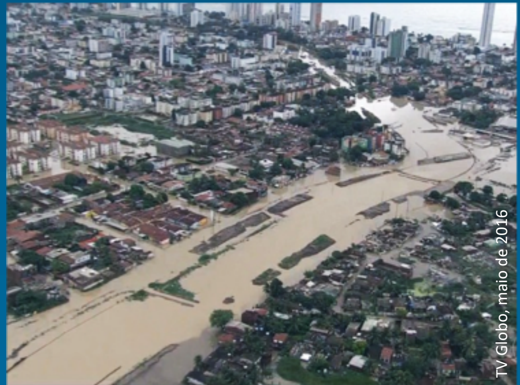
Canal do Córrego Frágoso, Olinda
