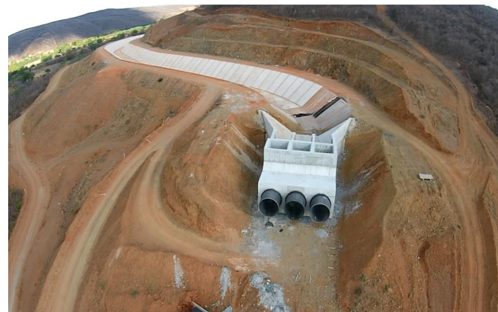
Vista do Sifão Beleza
