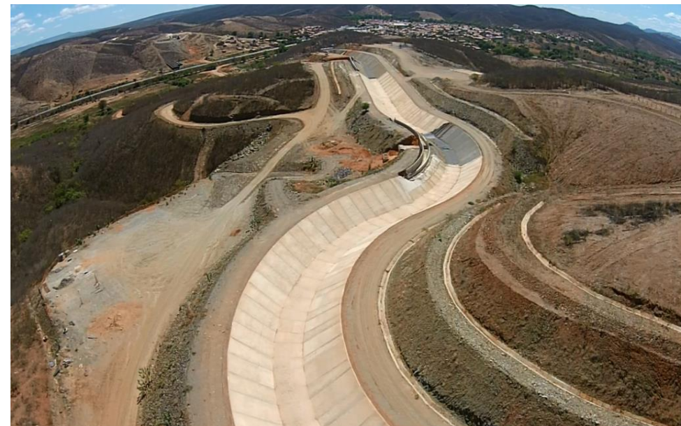
Vista do Canal 1
