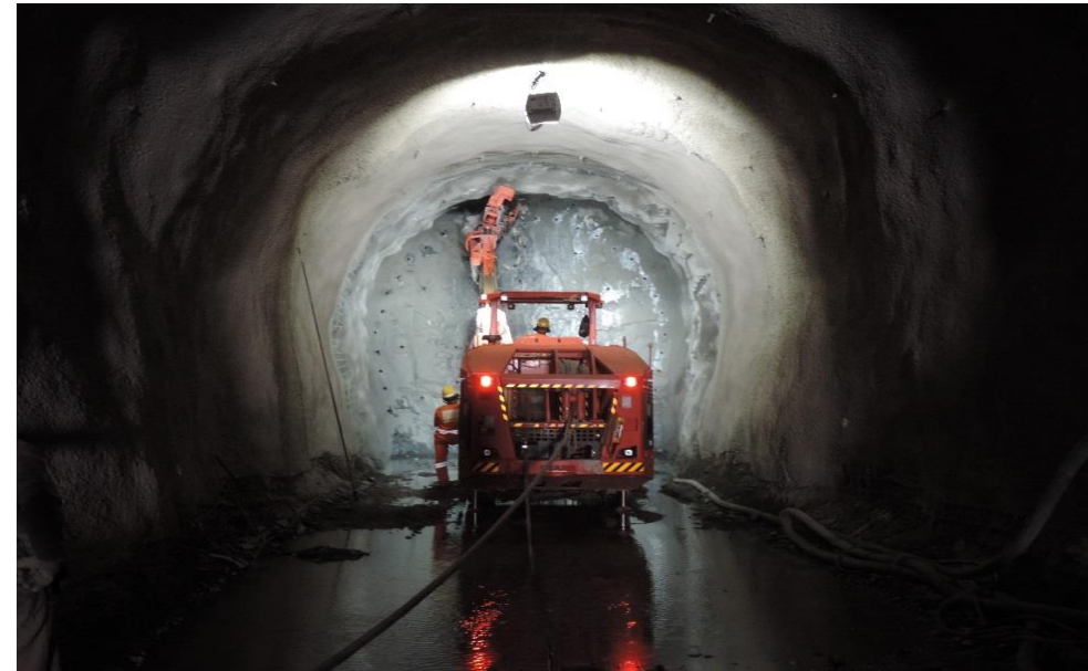
TÚNEL CRUZEIRO - Desemboque
