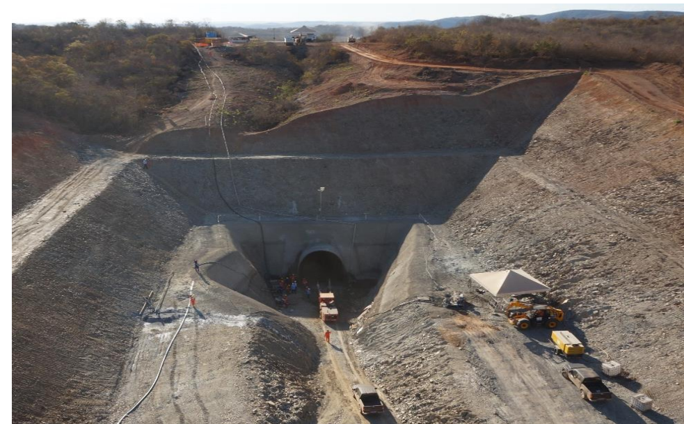
TÚNEL CARNAÚBA – Emboque
