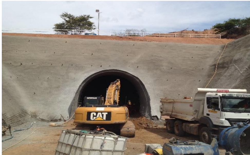
TÚNEL BOA VISTA – Desemboque
