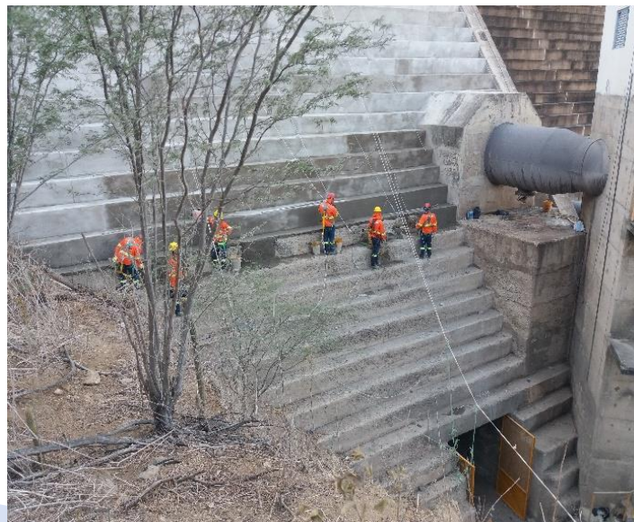
Reconstituição dos degraus, com emprego de argamassa
