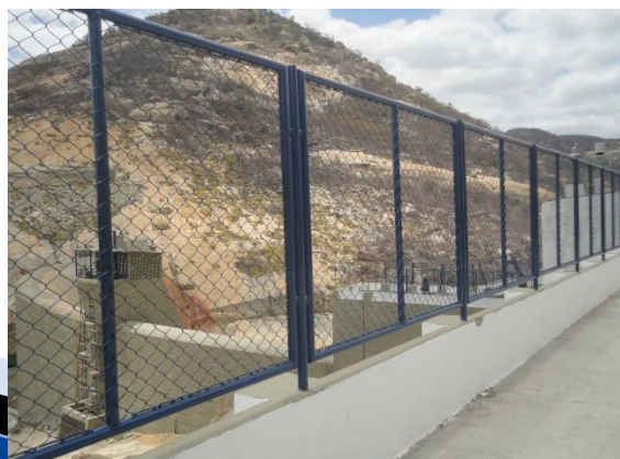
Instalação de alambrados
