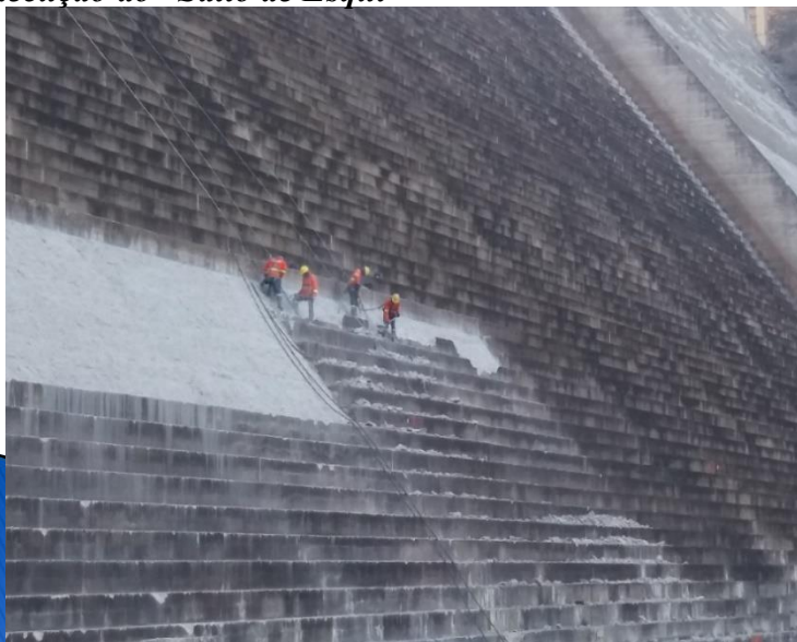
Demolição de degraus no canal de queda do extravasor principal, para execução do “Salto de Esqui”
