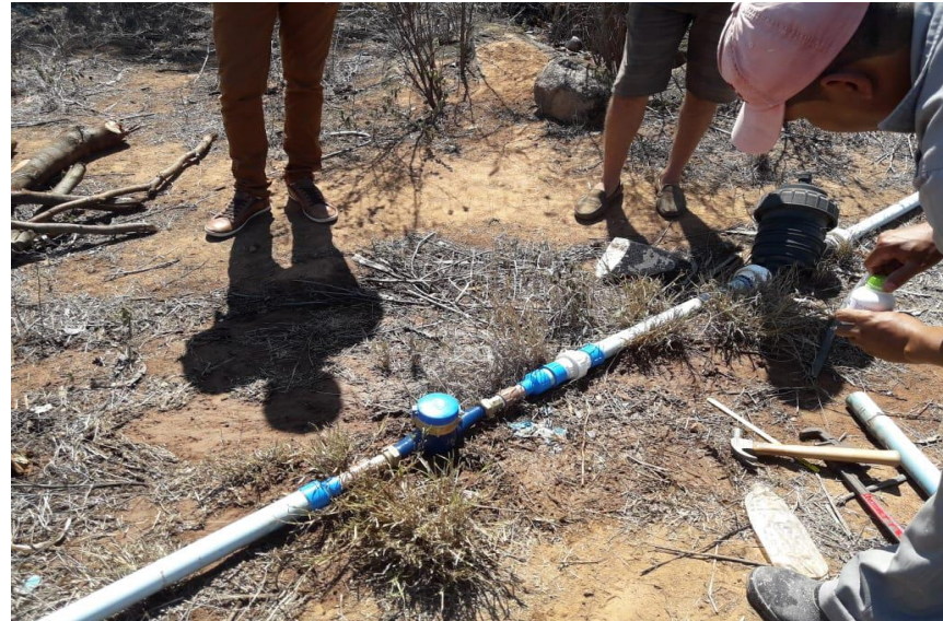
Figura 7: Instalação de Hidrômetro para medição do consumo de água.
