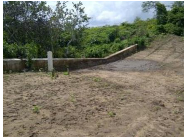
Figura 3. Vertedouro triangular
