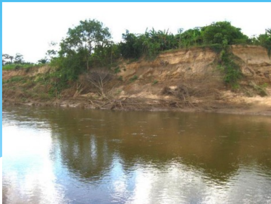
Figura 07. Margem esquerda do Rio Providência totalmente em colapso e vegetação sendo arrastada.
