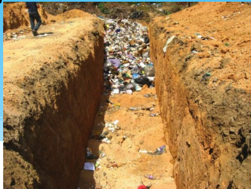
Figura 10 - vista parcial de valas na área da UTC.
