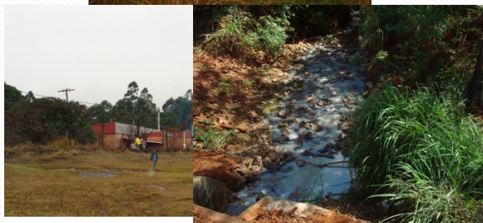
Caminho do Coletor Tronco do Córrego Harmonia lançamento de efluente "in natura"
