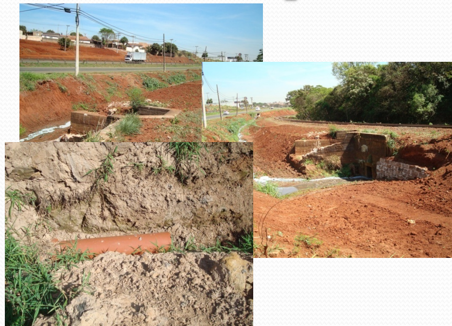
Córrego Harmonia - Passagem do Coletor Tronco (travessia e tubulação)
