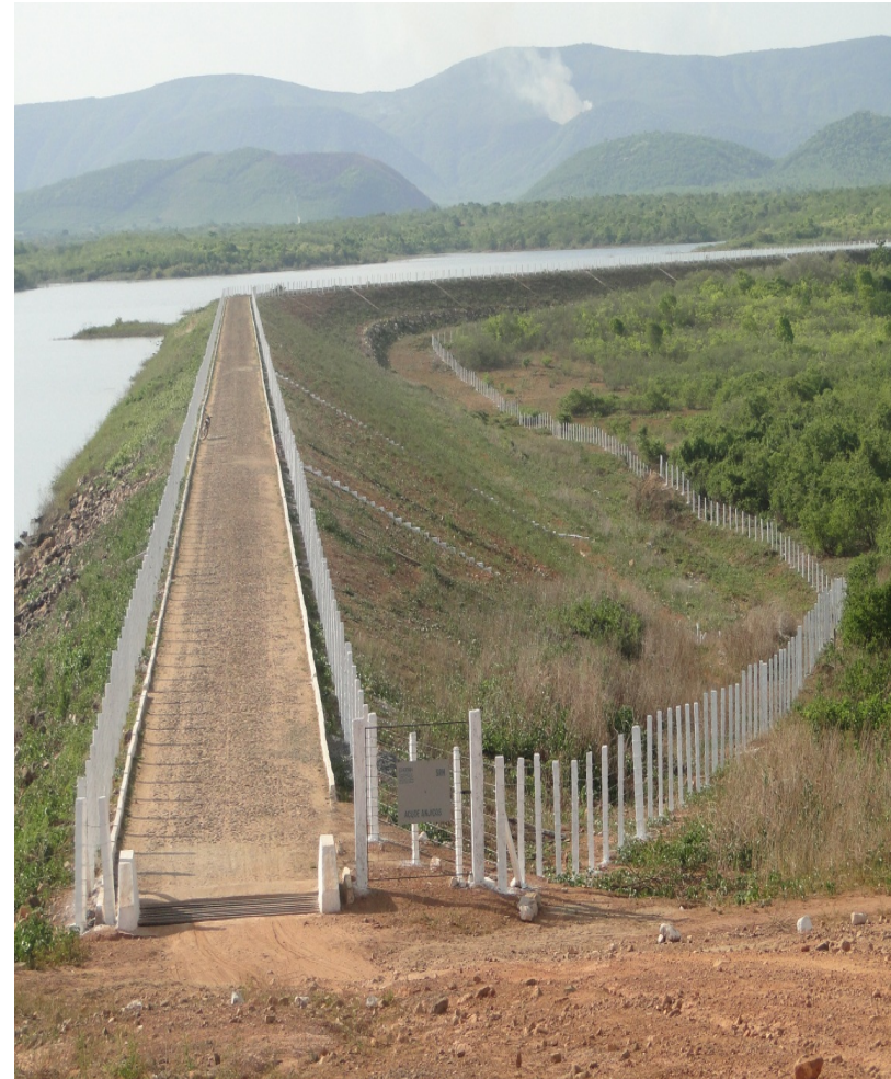
Vista da Barragem Angicos.
