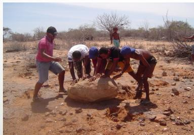
Dique experimental de retenção de sedimentos do CBZ na aldeia Pankará (Dike001), Neo-solos Litólico, microbacia de nascente do riacho Itacuruba (PE), 15 cm de sedimentos no primeiro ciclo hidrológico (PRODEMA/UFPE/INNOVATE).
