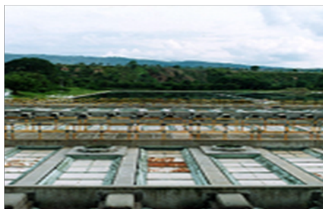
Água e esgoto
