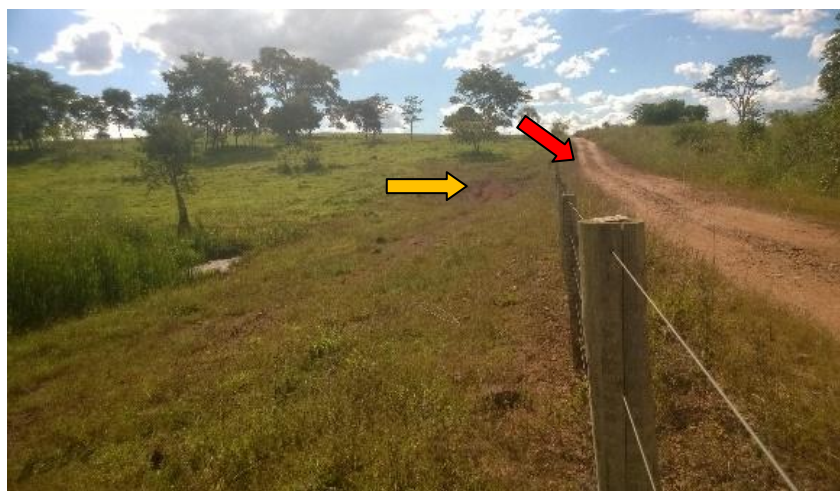
Figura 8 – Foto ilustrativa do ponto de intersecção da estrada com a linha de fluxo acumulado. A seta em vermelho indica a área de depressão na estrada e local de saída do escoamento superficial. A seta em laranja mostra os sulcos erosivos adjacentes à estrada, consequência da ausência de sistemas de drenagem.
