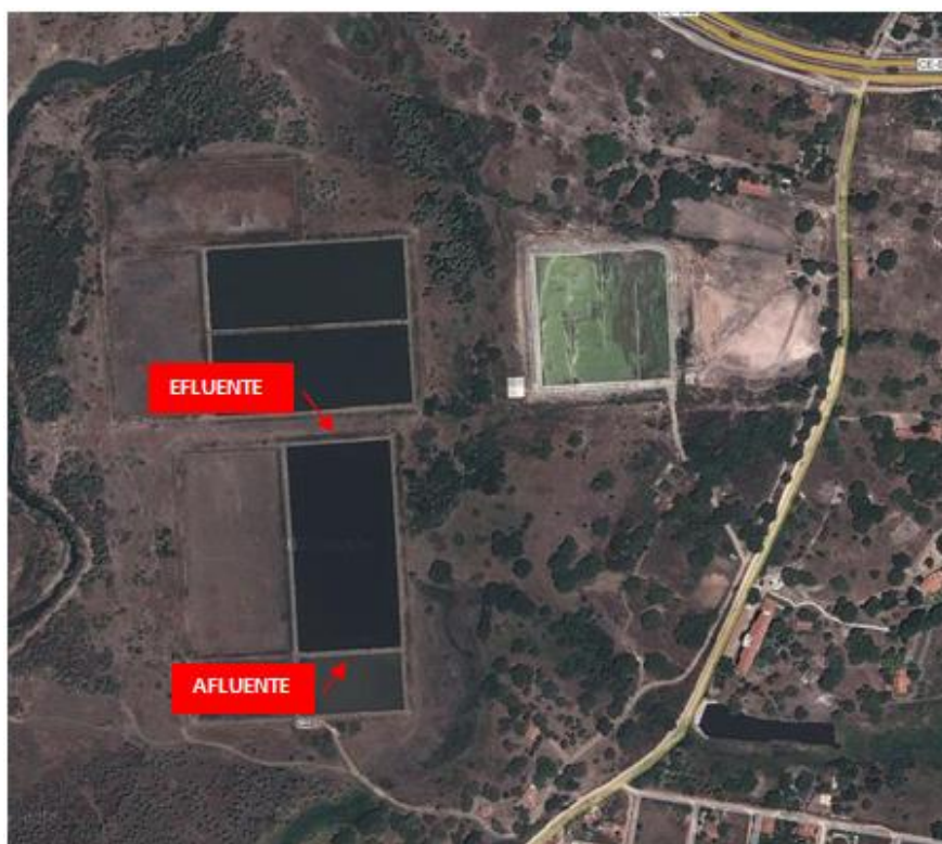
Figura 1 - Bloco de lagoas da ETE de Aquiraz – CE, com destaque para os pontos de coleta.
