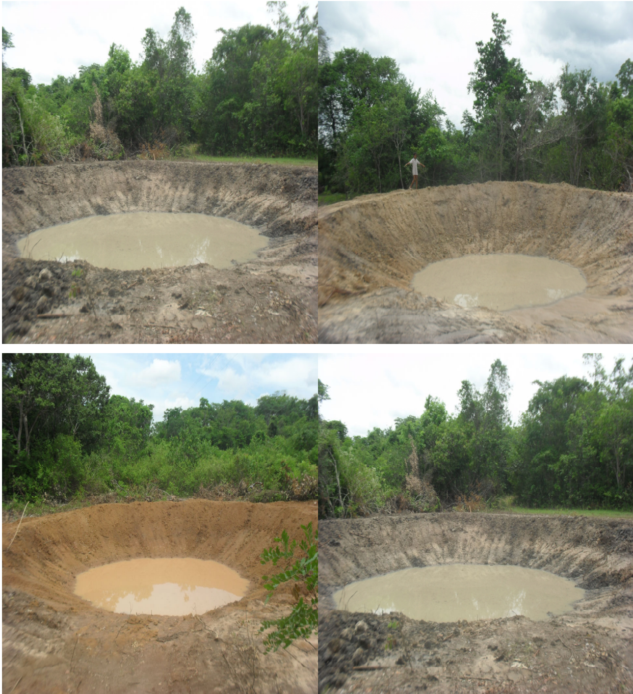
Figura 2. Barraginhas construídas na zona rural dos municípios de Conceição do Tocantins e Paranã.
