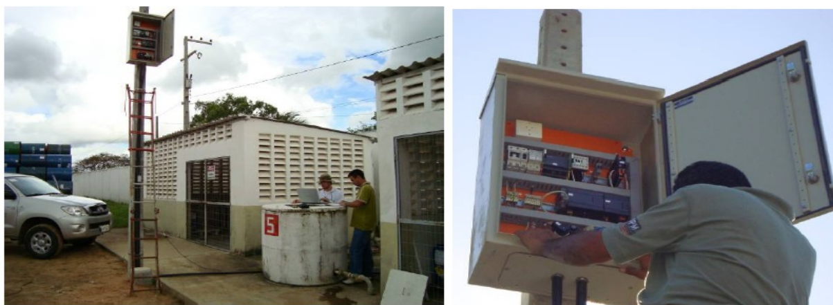
Figura 2: Estação de monitoramento por borbulhamento Fonte: COGERH 2013
