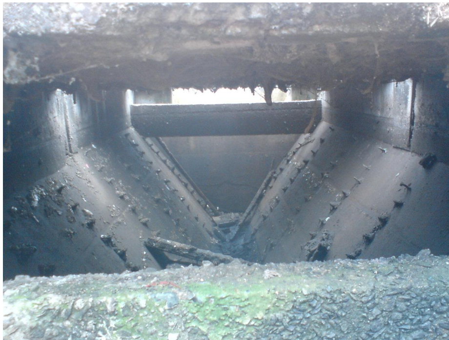
Figura 2 – Vista interna de um TI
