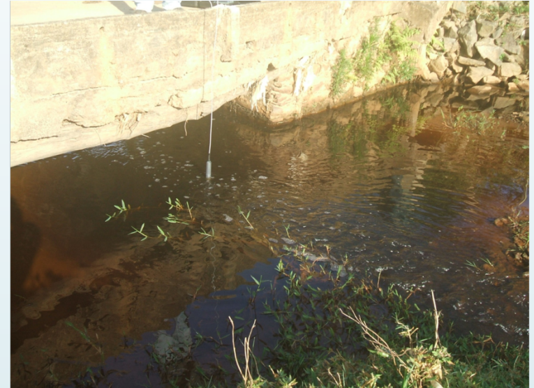
Figura 4: Córrego Salvaterra com derramamento aparente (P4).
