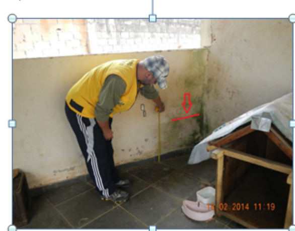
Foto 5.15. Área 15 – Vila Paulista. Indicação do nível de estingimento (Net=0,47m) em moradia situada junto ao talude de margem do ribeirão.
