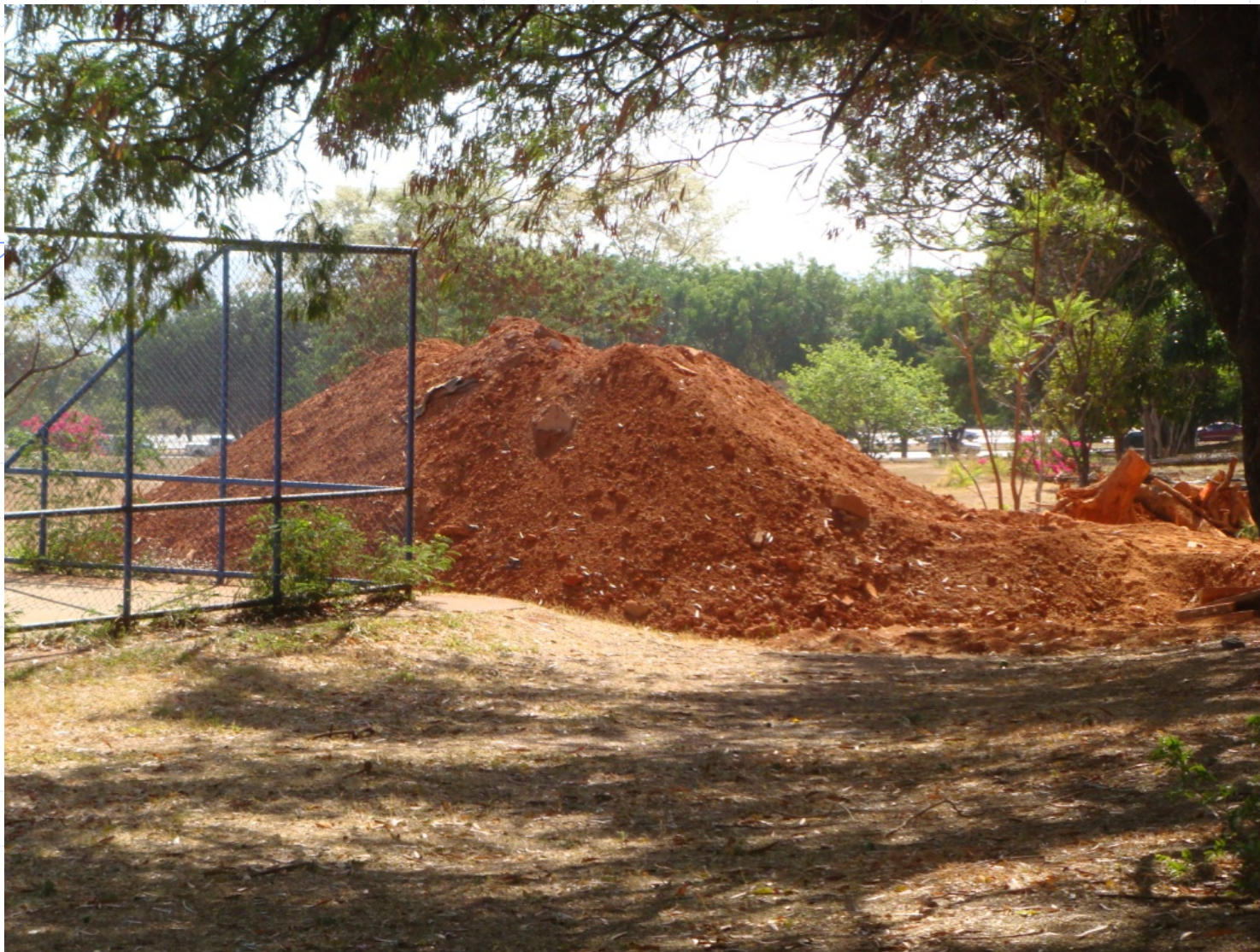
SQN 106 – obra de impermeabilização
